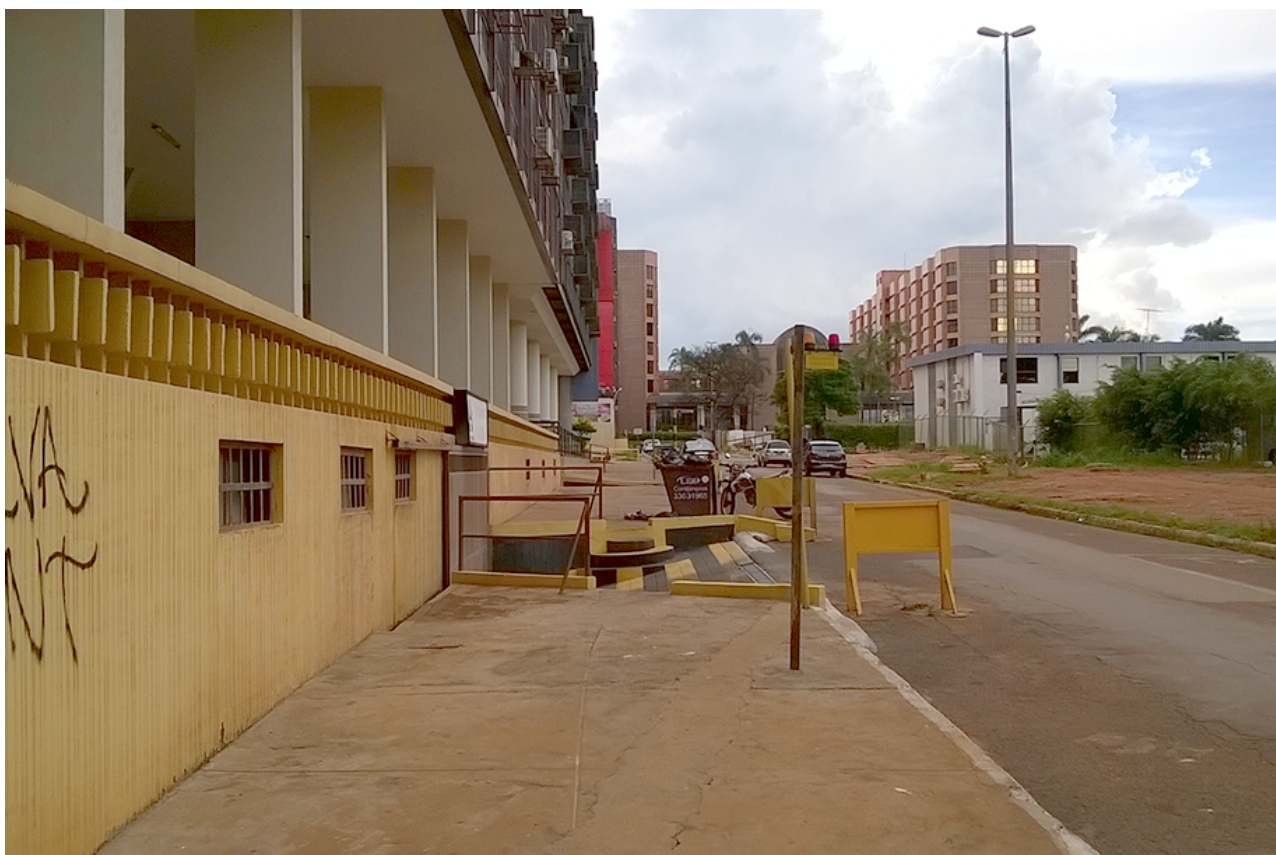
A rampa de garagem deste prédio em Brasília rompe a calçada, obrigando o pedestre a ir para a pista. (Imagem: Gabriela Tenorio)
