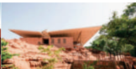
Parque Nacional de Mali, Bamako, Mali, 2010 Arquiteto: Francis Kéré.
